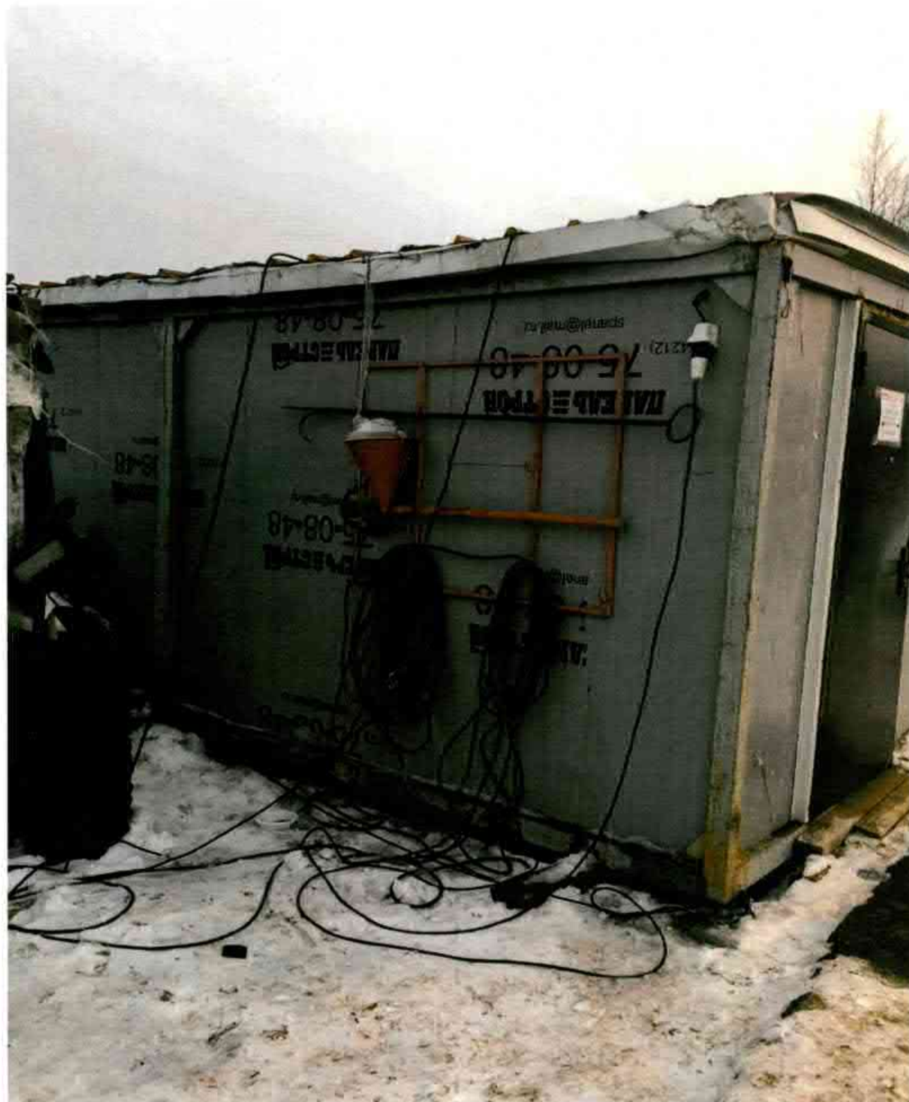
Фото № 19. В районе сооружения ЛОС № 9 пожарный щит укомплектован не в полном объеме.
